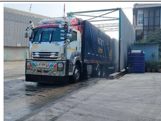
รูปที่ 2-5 การฉีดล้างรถบรรทุกบริเวณบ่อล้างล้อก่อนออกจากพื้นที่โครงการ
