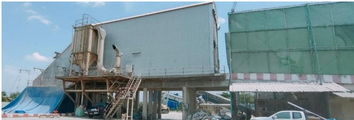
รูปที่ 2-6 เครื่องดักจับฝุ่น (Bag Filter) ติดกับโกรกลงสินค้า A พร้อมท่อดูดฝุ่นจากผ้าใบขณะมีการขนถ่าย สินค้าบริเวณโกรกลงสินค้า A รวมทั้งมีการติดตามถ่ายกันฝุ่นบริเวณทางขึ้นโกรกลงสินค้า A
