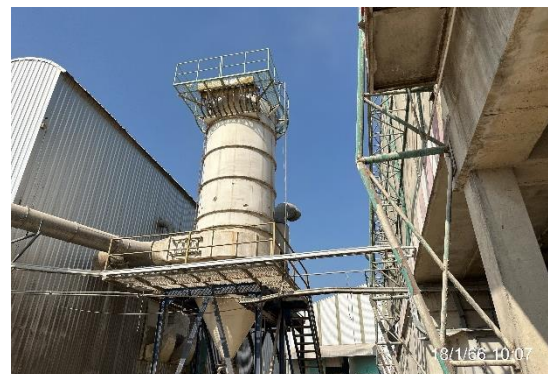
รูปที่ 2-7 เครื่องดักจับฝุ่น (Bag Filter) ติดกับโกรกลงสินค้า B พร้อมท่อดูดฝุ่นจากสายพานลำเลียงมันเส้น
