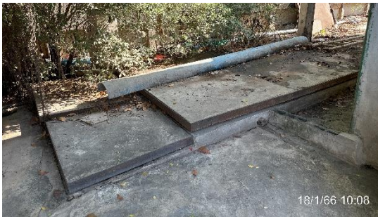
บ่อพักน้ำทึ่ก่อนระบายลงสู่แม่น้ำป่าสัก
