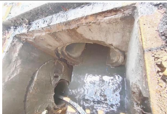
รูปที่ 2-46 ท่อ คสล. Ø 0.8 เมตร ที่ระบายน้ำลงสู่แม่น้ำป่าสัก
