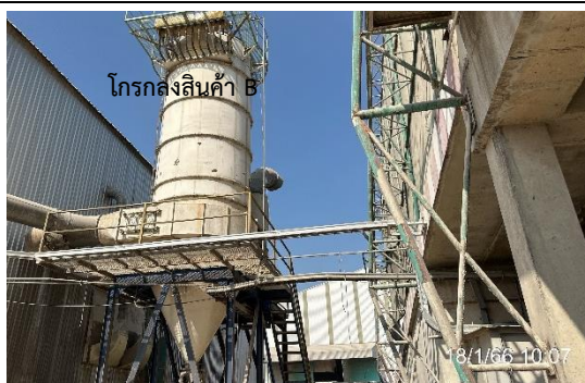
รูปที่ 2-22 ทิศทางของปลายท่อเครื่องดักจับฝุ่น (Bag Filter) ของโกรกลงสินค้า A และโกรกลงสินค้า B
