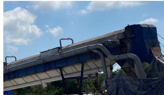
รูปที่ 2-26 ท่อดูดฝุ่นจากผ้าใบเข้าสู่เครื่องดักจับฝุ่นบริเวณโรงกลั่นสินค้า
